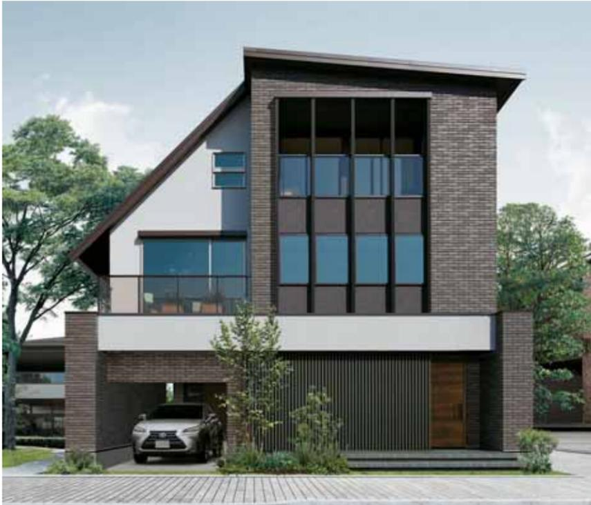
して商品化したもの。高度斜線や日影規制に対応する急勾配屋根と、太陽光発電パネルをより多く搭載できる緩勾配屋根を併用する異種勾配屋根を新規に開発。木造3階建ての軒高9.5m規制や日影規制など、周辺環境や法規制のギリギリまで空間を有効活用する。
