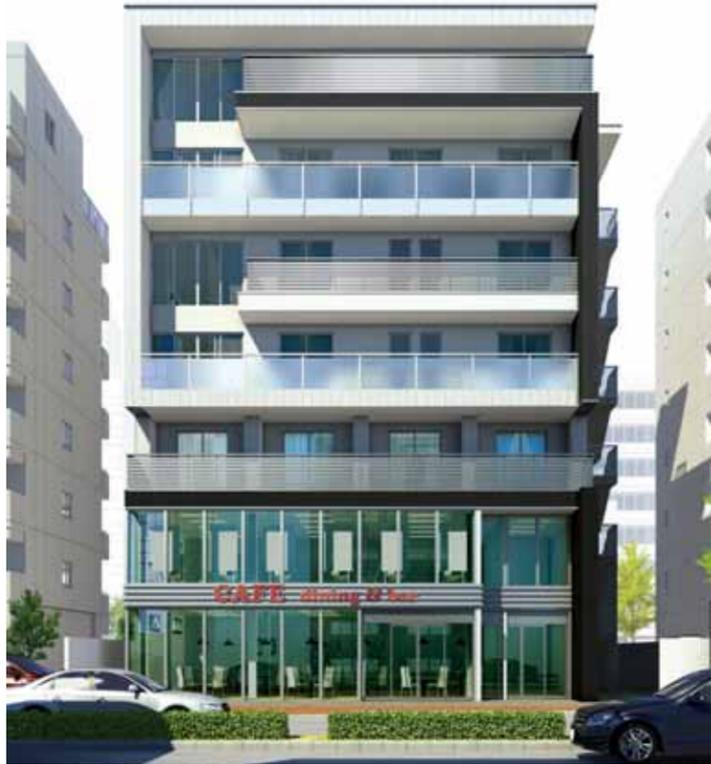
各階の階高を2・8〜3・5の範囲で設定可能で、複雑な配管を納められる最大700mmの天井裏懐やスラブ上の配管スペースの確保が行える。
