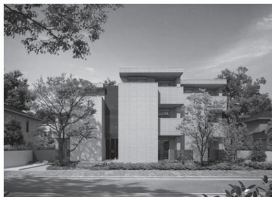
敷地条件への対応力と高い耐震性を併せもつ重量鉄骨システムラーメン構造の3階建て賃貸住宅「ヘーベルメゾン プラネックス 3」。
